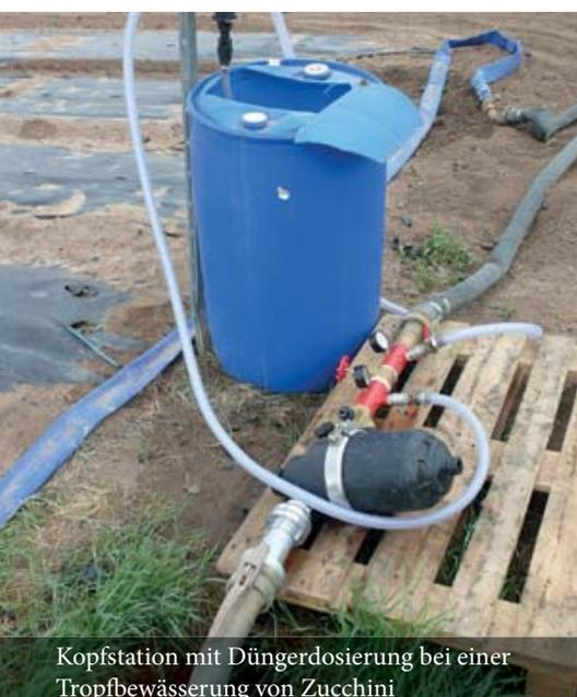
Kopfstation mit Düngerdosierung bei einer Tropfbewässerung von Zucchini
