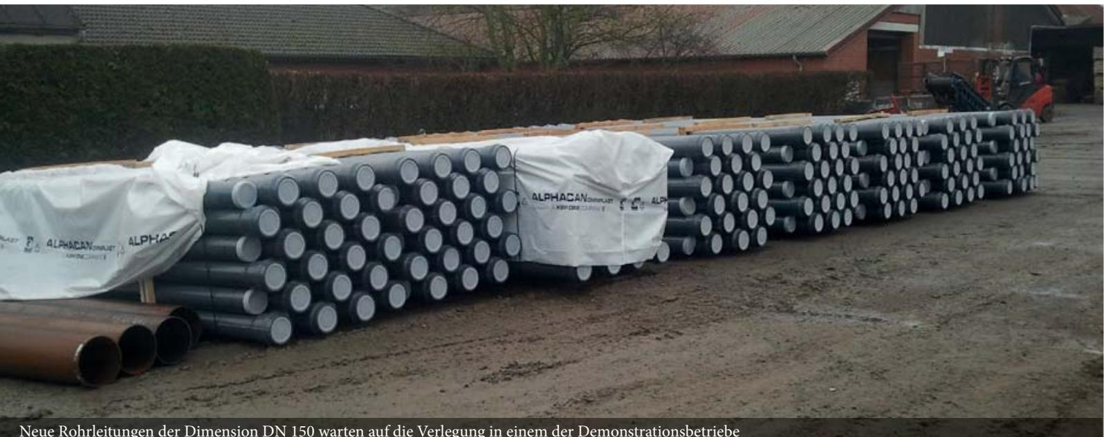
Neue Rohrleitungen der Dimension DN 150 warten auf die Verlegung in einem der Demonstrationsbetriebe
