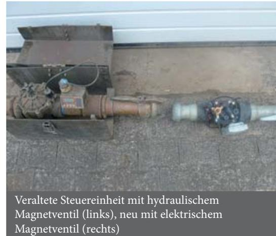
Veraltete Steuereinheit mit hydraulischem Magnetventil (links), neu mit elektrischem Magnetventil (rechts)
